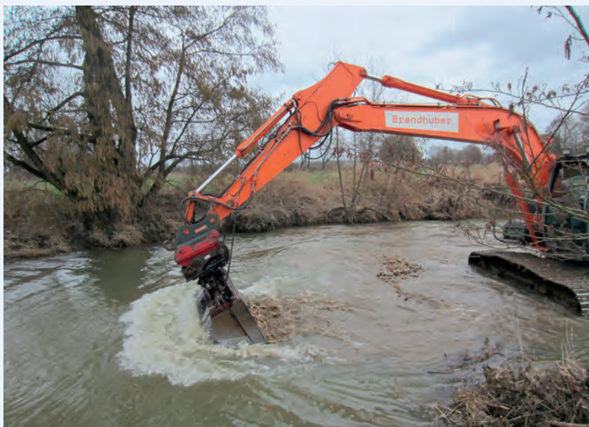
Im Mai 2016 rückte der Bagger an, um Kieslaichplätze in der Kollbach zu sanieren und so die Wiederbelebung mit Mikroorganismen und Jungfischen zu beschleunigen.
